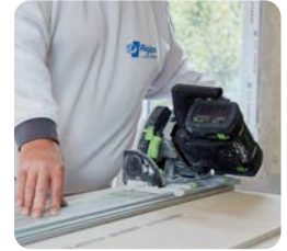
Für den Wandanschluss ist der Stufenfalz abzutrennen
