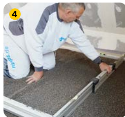
Planebene Schüttungs- oberfläche
