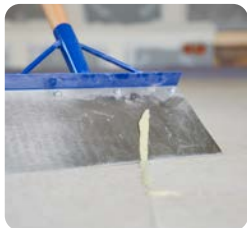
Überschüssigen erhärteten Kleber abstoßen
