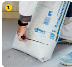
Sack unten aufschneiden
