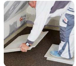
Verlegung der Estrichelemente auf Rigidur Ausgleichsschüttung mit Hilfe von Laufinseln
